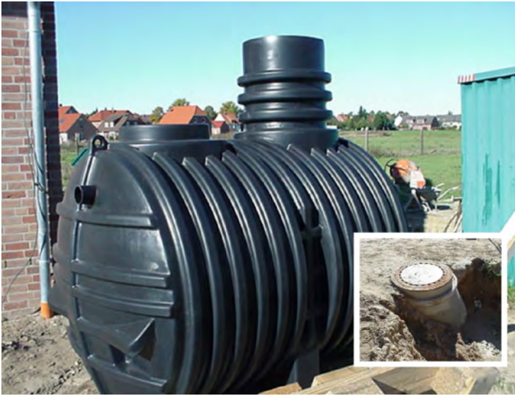
Abb. 5: Regenwassersammlung im Green Building (Quelle: Bethe)
