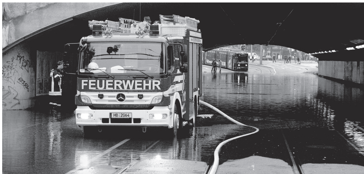
Abpumparbeiten nach einem Starkregenereignis im Gustav-Deetjen-Tunnel
